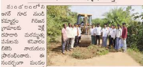
మరమ్మత్తు పనులను ప్రారంభిస్తున్న ఇజిపీ నాయకులు
